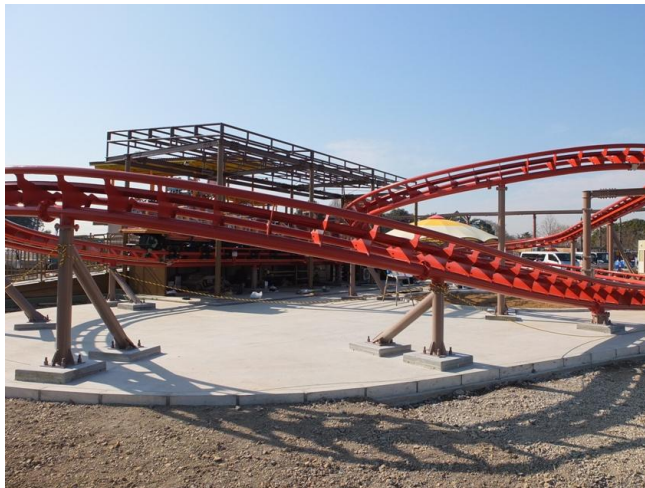
ディギーとダギーのトロッココースター(建設中)
