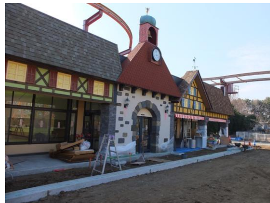
コルネさんのパンケーキハウス外観(建設中)
