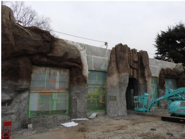
ヒグマの森工事中 2016.2.29(外装) ↑
