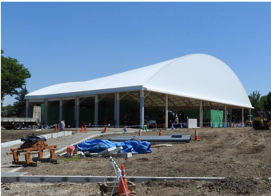
【建設中の新イベントスペース】
